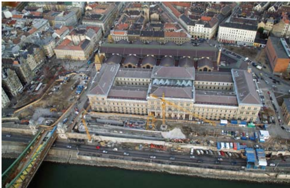
A Fővám téri állomás építése februárban
