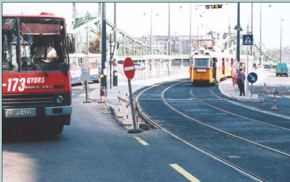
Az ideiglenesen átadott út- és villamospálya
