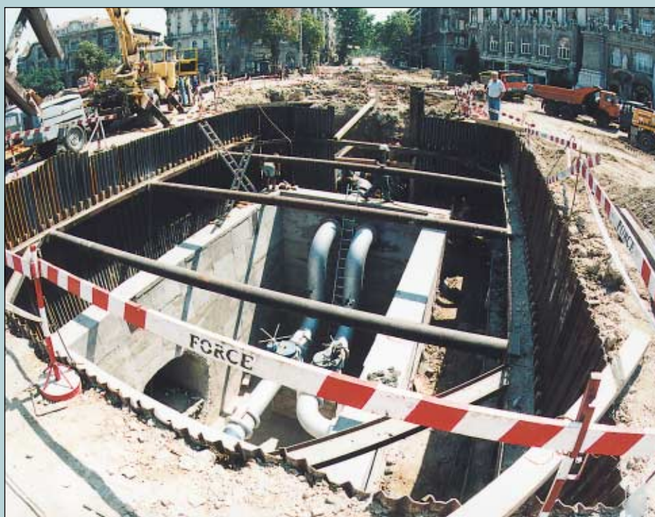
Szt. Gellért tér – a távfűtő akna átépítése
