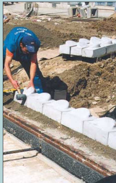
A speciális gömbsüvegsor építése
