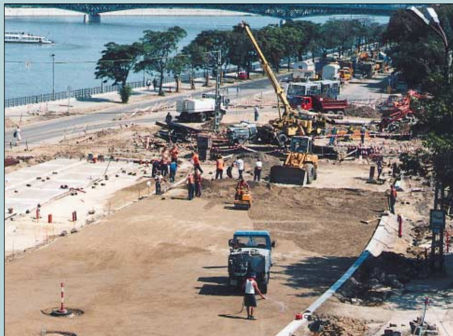
Szt. Gellért tér – közmű- és villamospálya-építés
