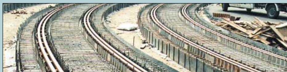
Szt. Gellért tér – különleges pályaszakasz építése a kissugarú ívekben
