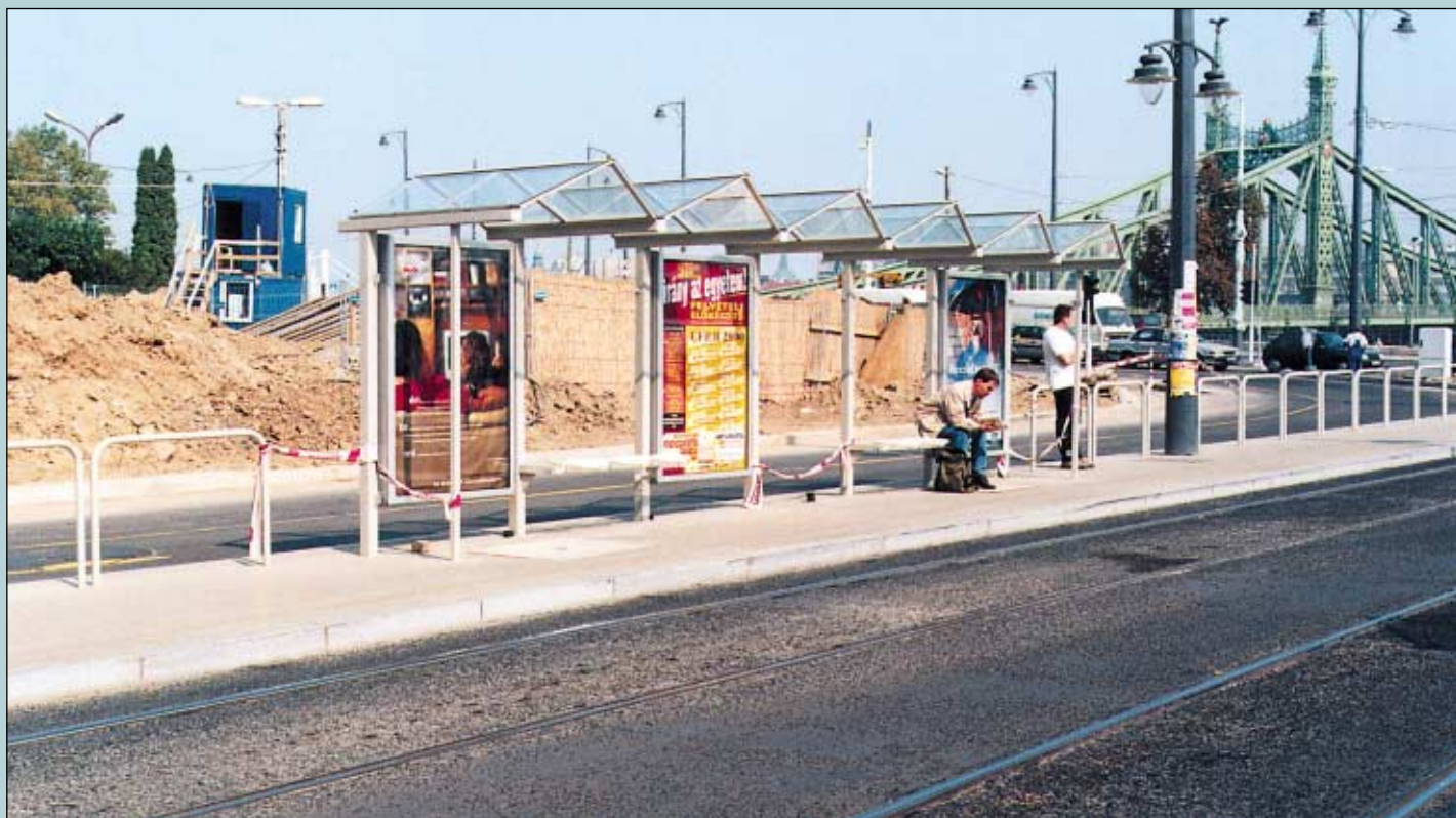
Szt. Gellért tér – az üzembe helyezett villamosmegálló
