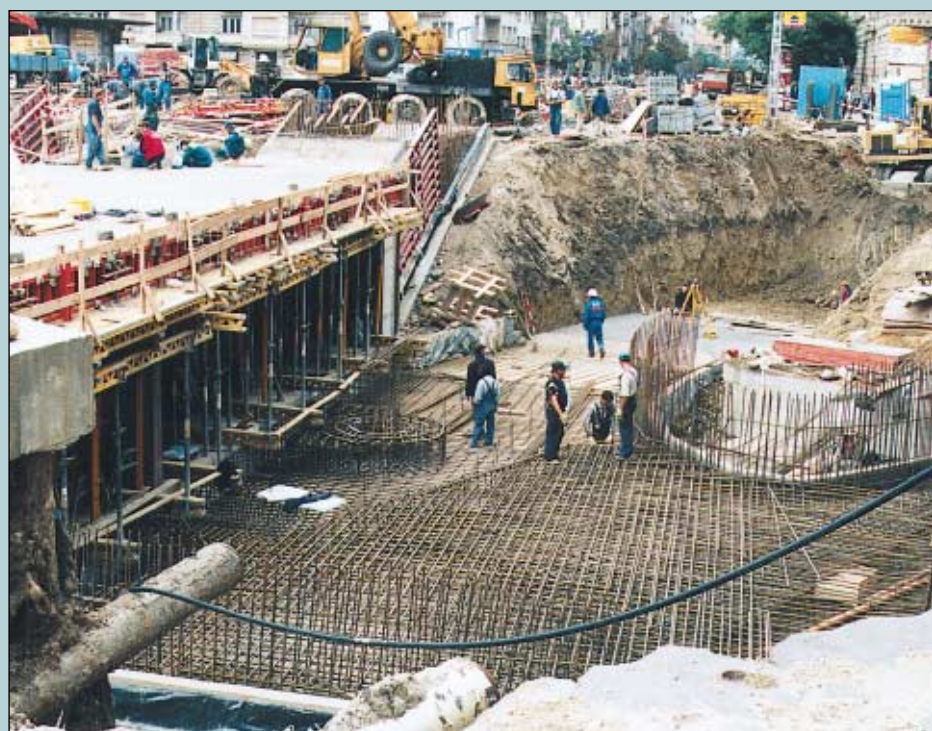
A Móricz Zsigmond körtéri aluljáró alaplemezének szerelése
