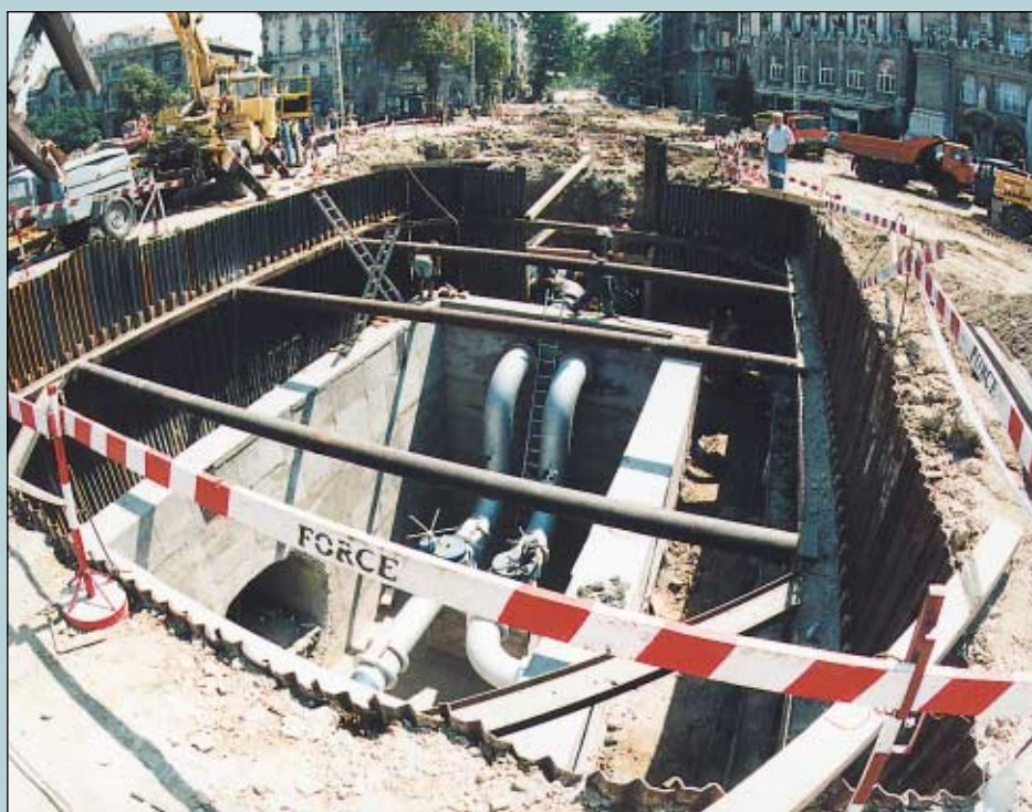
Szt. Gellért tér – a távfűtő akna átépítése
