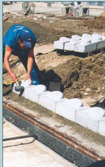
A speciális gömbsüvegsor építése
